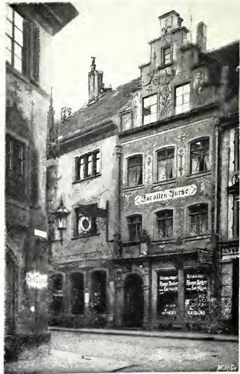
Burseneingang in der Eisenbahnstrasse. Architect: Franz von Hoven in Frankfurt a. M.
